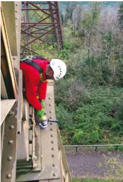
2. Maestranze al lavoro per la manutenzione del ponte San Michele
