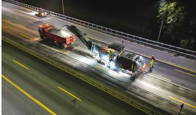
4. Una fresa Wirtgen dotata di sistema 3D UTS Trimble PCS 900
